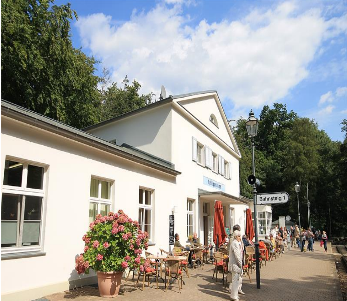
Ansicht Bahnhofseite mit Sonnenterrasse – Süd – West - Ausrichtung
